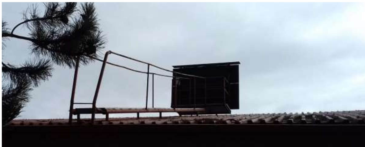
Obrázek č. 7 – Výsledková tabule a střešní lávka
