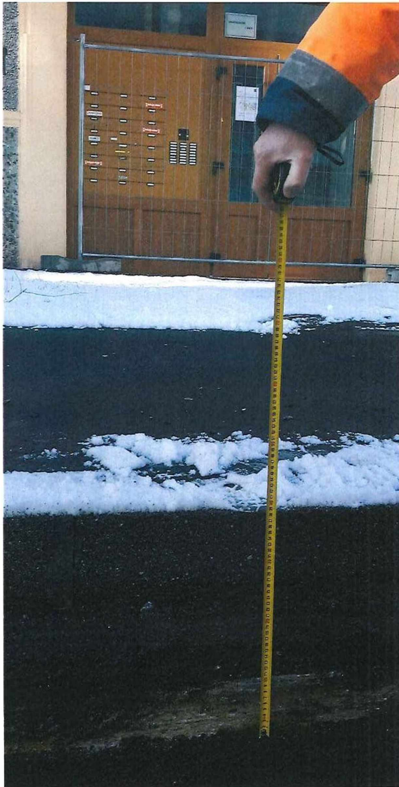
Měření tloušťky asfaltového koberce před č.p. 1969, km 0,250
