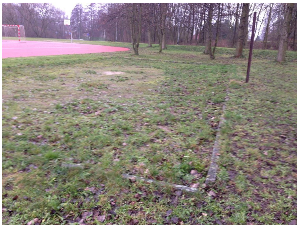
SO 04 - Plocha pro pétanque - stávající stav obrubníků, prorůstání trávy
