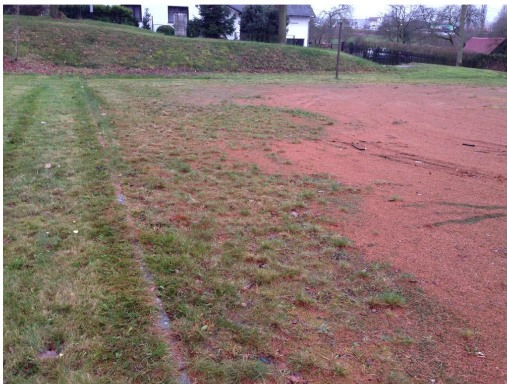
SO 01 - Plocha pro volejbal - stávající stav obrubníků, prorůstání trávy
