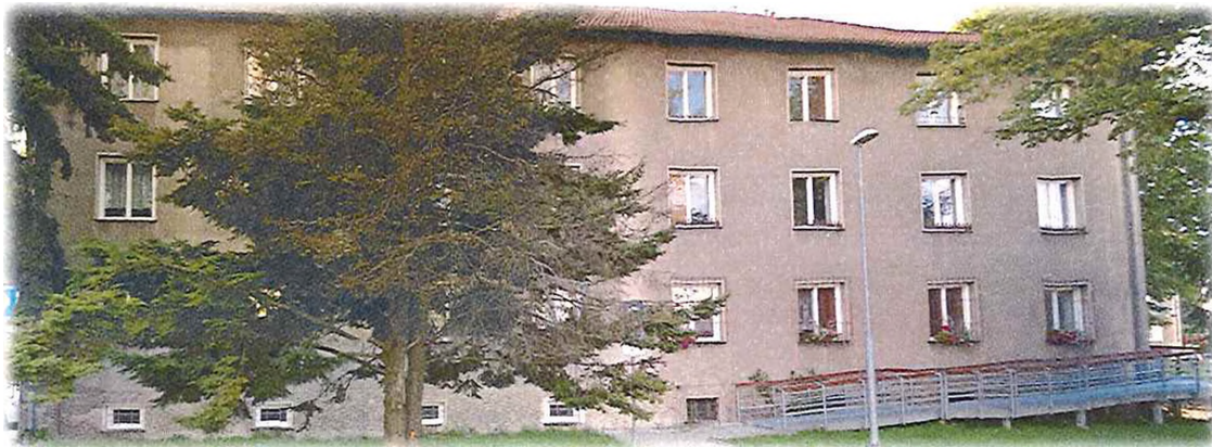
Celkový pohled na budovu.
