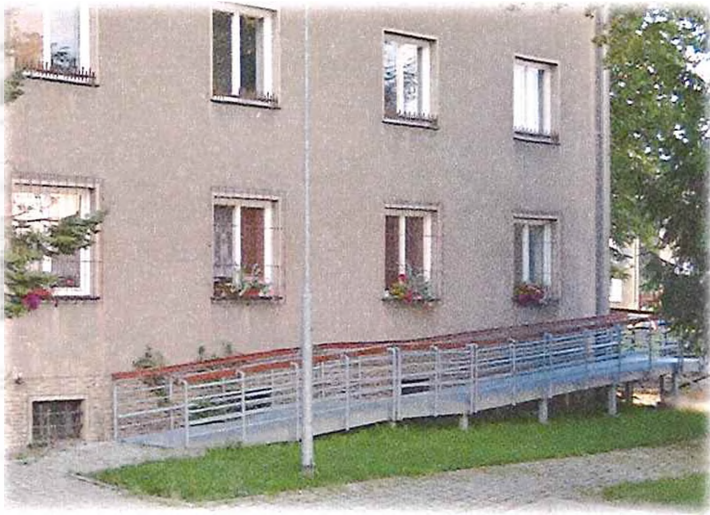
Pohled na budovu s rampou pro invalidní osoby
