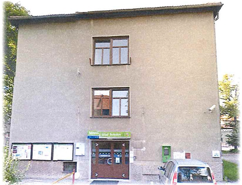
Pohled na budovu od hlavního vchodu. Výplně otvorů nejsou předmětem této VZ (již realizováno).
