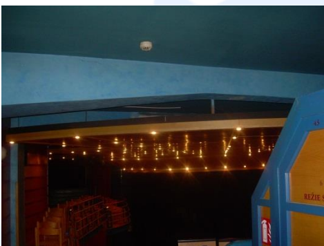
Divadlo, pohled z vrcholu hlediště na jeviště, hlásič EPS
