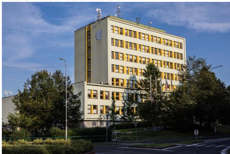
Budova Městského úřadu Sokolov
