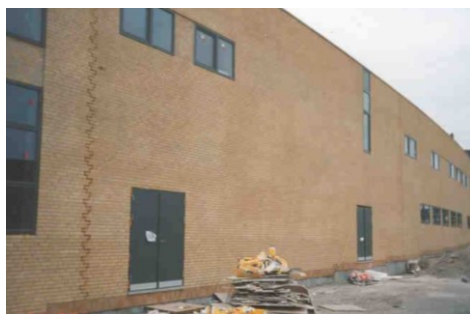
Ukázka provedené dilatační spáry v obkladu.
