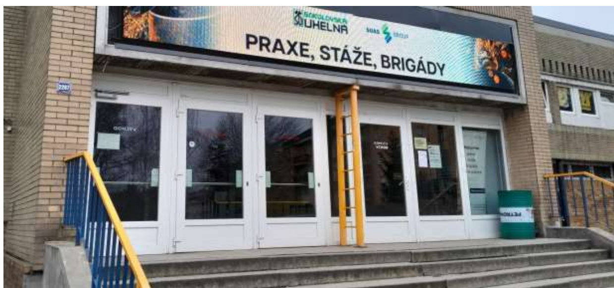
Obrázek č. 2 a 3 – Hlavní vstupní dveře zimního stadionu – vnější a vnitřní pohled
