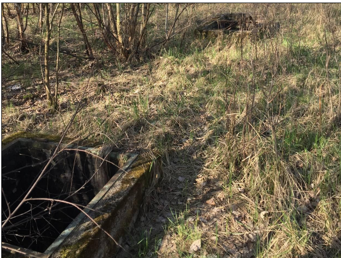
Foto č. 12 - Objekt č. 2x podzemní ocelová nádrž 100 m 3
