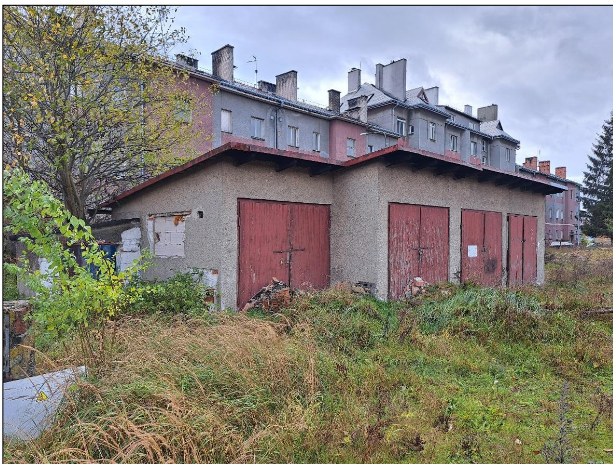
Foto č. 2 - Objekt č. 2. garáže
