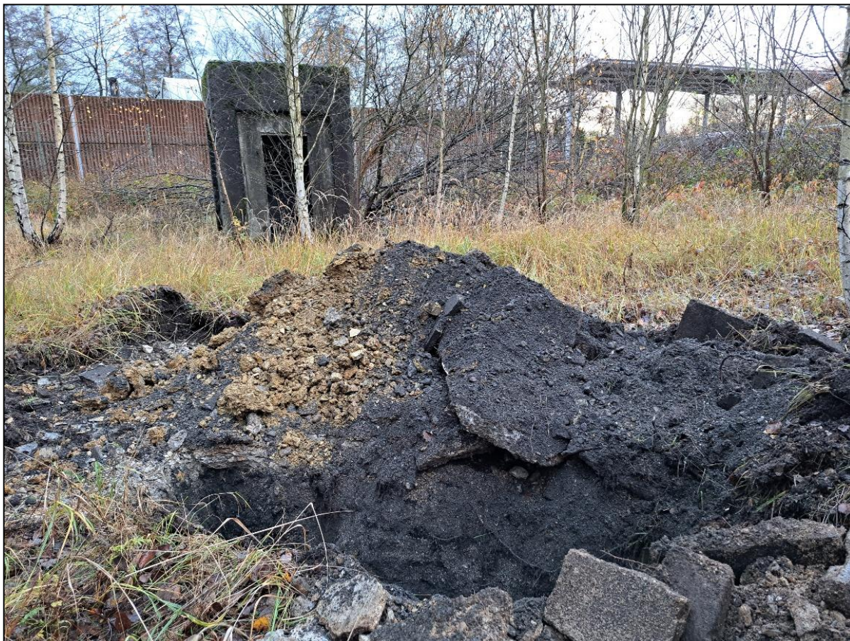
Foto č. 13 - Objekt č. 17. železobetonový sklad
