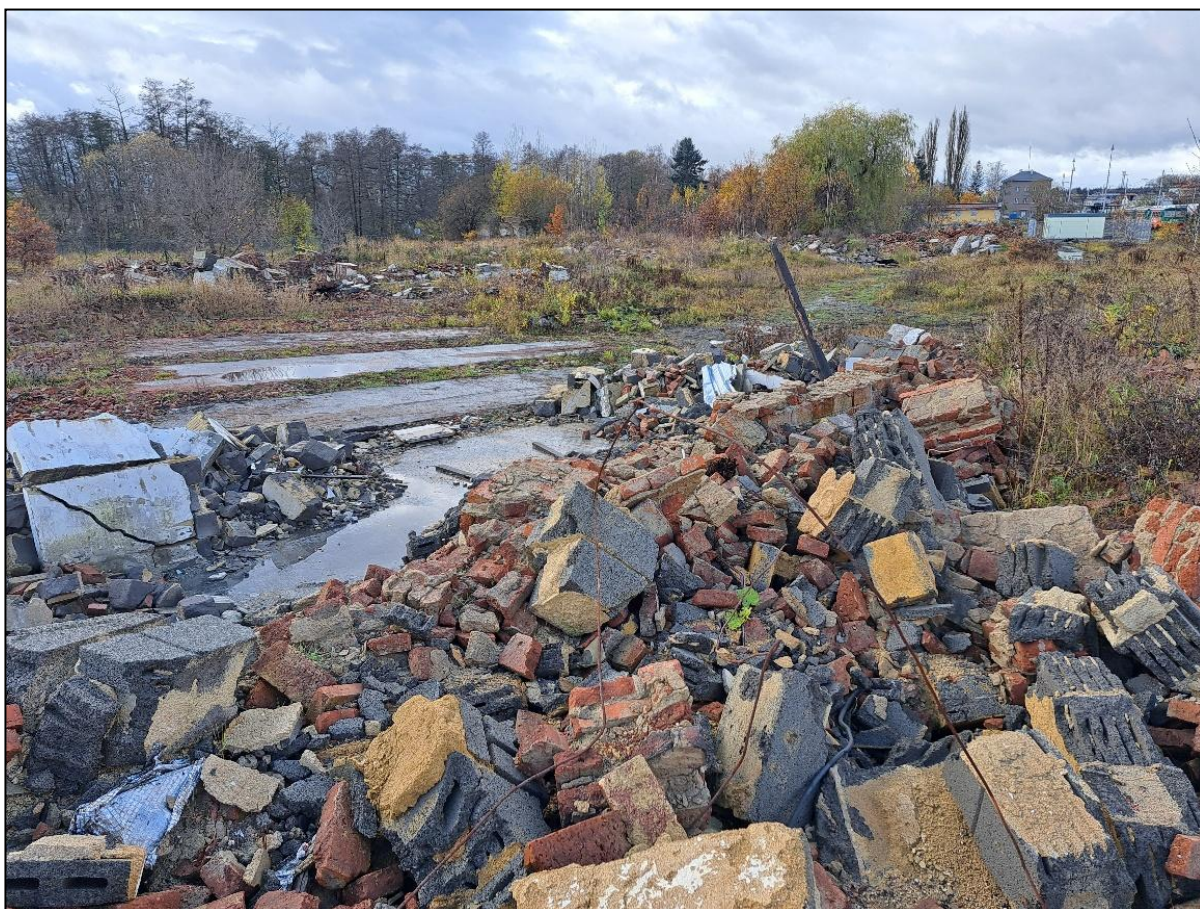
Foto č. 6 - Objekt č. 9. velká rotunda a dílny
