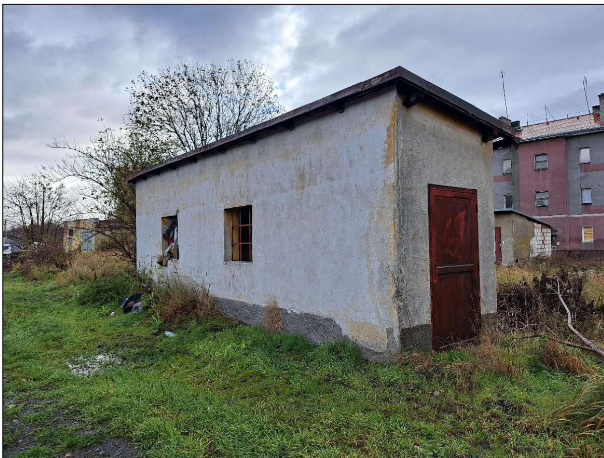
Foto č. 3 - Objekt č. 3. stavba technického vybavení
