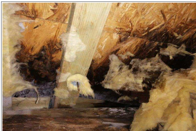
Foto /3/ Degradované dřevěné části střechy
