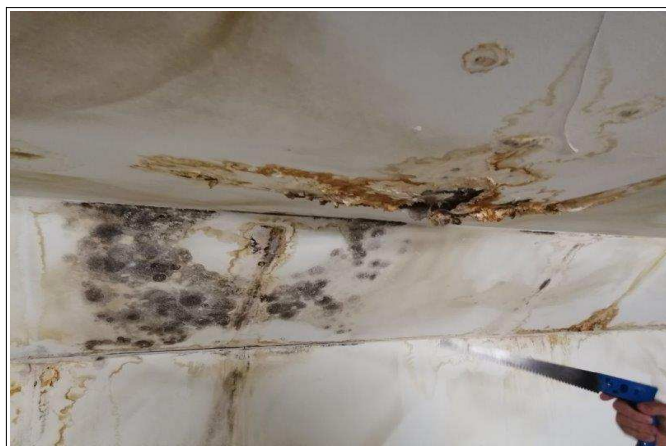
Foto /1/ Stopy vlhkosti na SDK podhledu
