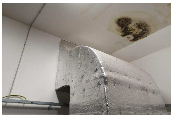
Foto /2/ Stopy vlhkosti na SDK podhledu
