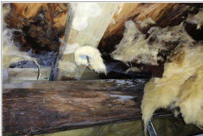
Foto /4/ Degradované dřevěné části střechy
